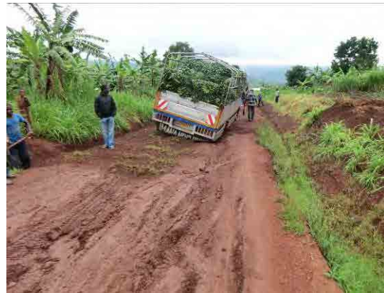
降雨の後の道路状況（2）
