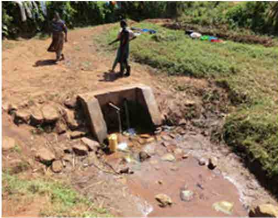
写真 - 9 : コンクリートで保護された保護湧水 (ンゴマ郡 ルキラ セクター)
