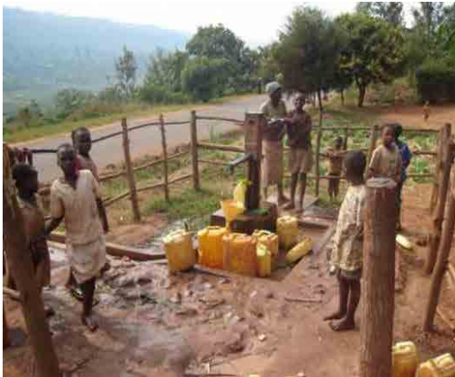
写真 - 3 : 既存のハンドポンプ付深井戸 (ンゴマ郡 ムラマ セクター)
