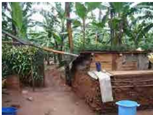
キレヘ郡 Gatore サイト民家の雨水集水施設
