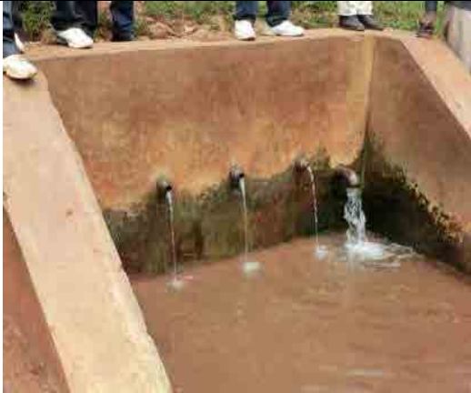
写真 - 7 : コンクリートで保護された保護湧水 (カヨンザ郡)
