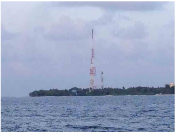
ピリングリ島のアンテナ鉄塔 (マレ島から撮影)
