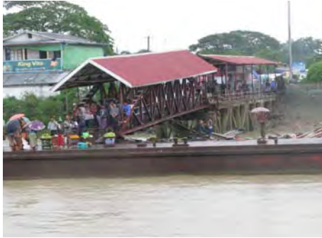
Existing Dalla Jetty (1)
