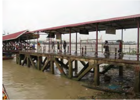
Existing Dalla Jetty (2)
