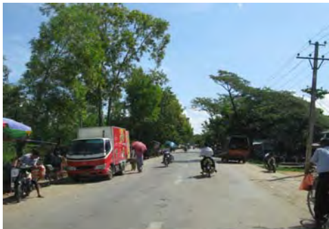
Access Road to Dalla Jetty (3)
