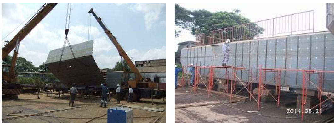
写真 10.2 ポンツーンの建造状況
