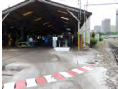
Hangar d'entretien et de réparation de roues.
