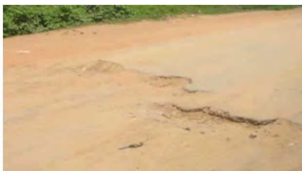
Figure 1.2 Dégradation de la Chaussée
