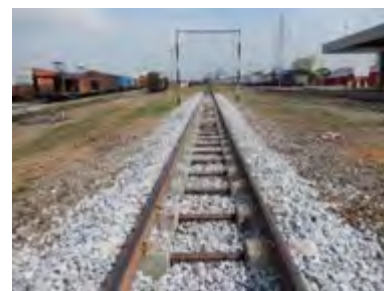
Voie d'inspection après entretien par bourreuse
