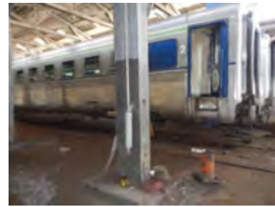
Hangar de réparation de wagon passagers
