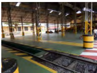
Hangar de matériel d'entretien de voies ferrées
