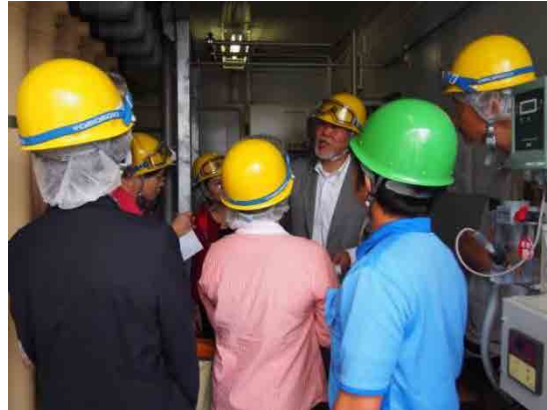
写真：マイクロザ MF モジュールが設置されたコンテナ内。設備の運転状況と水質は、常時遠隔監視されている。
