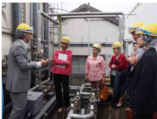
写真：マイクロザ MF モジュールが設置されたコンテナの外で、全体概要を説明。マイクロザ MF 除濁装置により、ミクロンオーダーの濁質も除去、シャットアウトし、クリーンな水を供給する。
