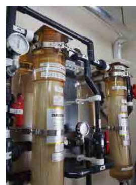
写真：多人数用透析液供給装置 (日機装) (左) 及び 透析液の清浄度を保つための UF フィルター (右)
