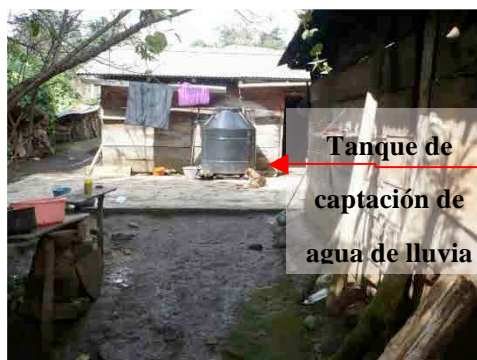
Foto: Tanque de almacenamiento que capta el agua de lluvia desde canaletas colocadas en ambos lados
