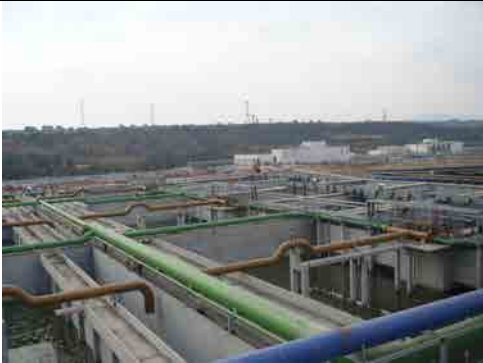
アトトニルコ下水処理場建設現場
