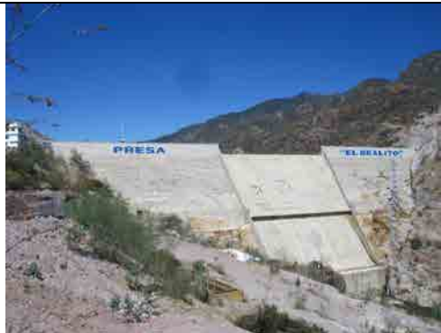
エルレアレットダム
