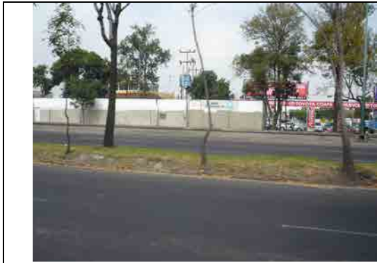
メキシコ市上水道用井戸施設
