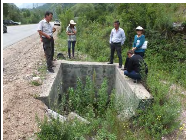
関係機関との合同現地踏査
