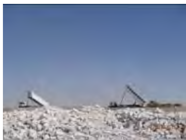
写真17 建設・解体廃棄物の埋立
