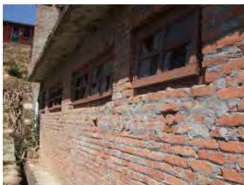
写真 5－1 無補強煉瓦造の2階建校舎
