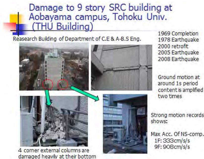
図 9－1 過去の地震ののちにレトロフィットした9階建のビルの被害
