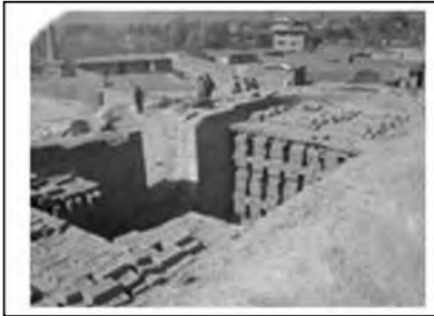
4. 炉内への生煉瓦の積み上げ
