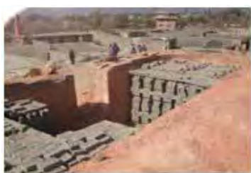
4. 生煉瓦の炉内への積み込み
