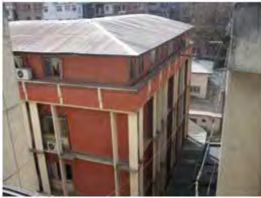
写真 5－3 無補強煉瓦造のBir 病院のI.C.U棟
