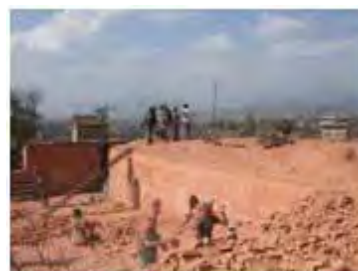
6. 焼煉瓦の取り出し
