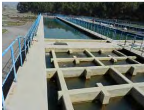
写真 6－6 Manohara 浄水場 沈殿池、ろ過池
