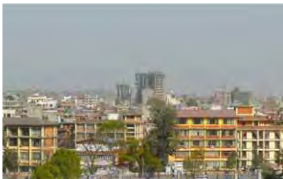
市街地での高層ビルの建設
