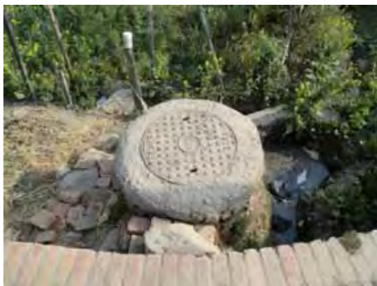
写真 6－7 下水ネットワークのマンホール
