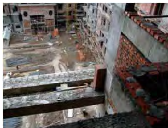
写真５－９ 建物はコの字型で、中庭部の俯瞰、足場もなく仮設の人用リフトもない
