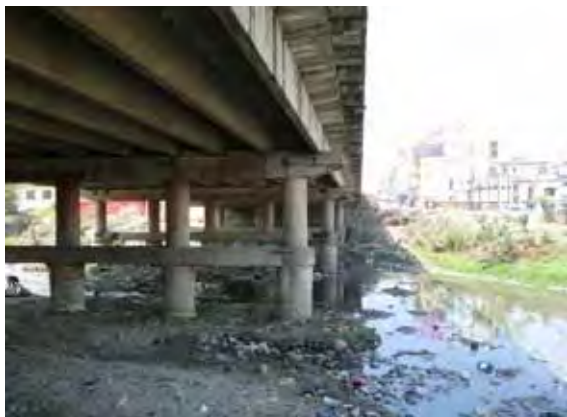
盆地内の主要道の橋梁
