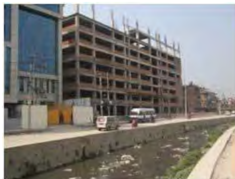
写真 5－2 細いRC骨組と煉瓦壁の高層化
