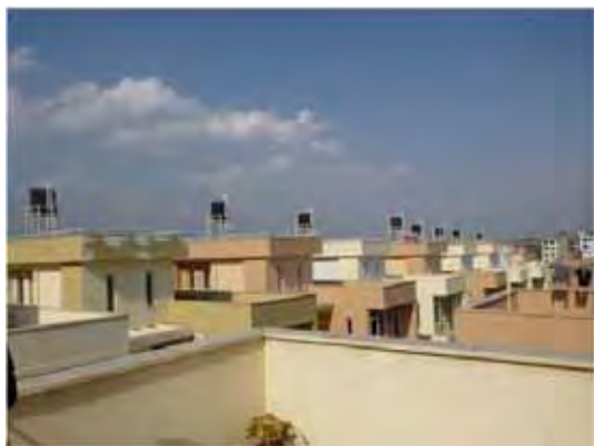
写真 4－5 屋上からみたニュータウン
