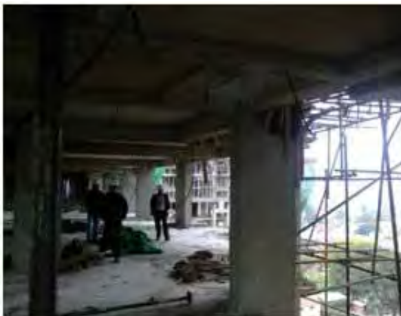
写真 5-10 上層階の内部、コンクリートは25～30MPaで比較的良好な仕上がり
