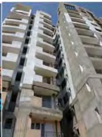
写真 4－8 高層アパートメント近景
