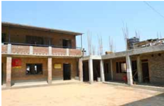
学校校舎の耐震補強（左）と新築（右）
