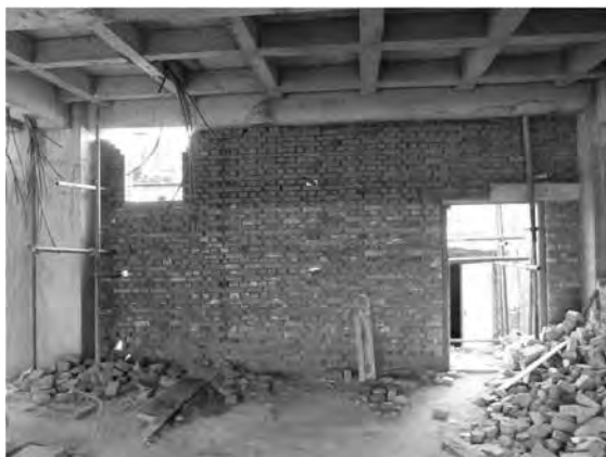
商業施設建設現場風景
