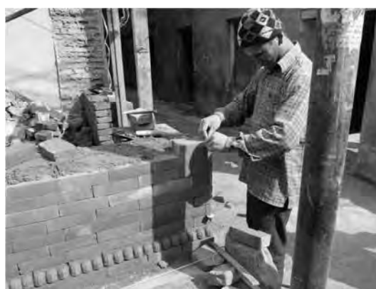
Adarsha Higher Secondary School (耐震補強した校舎に隣接する建物の建設現場)
