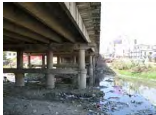
写真6-1 盆地内の道路橋梁
