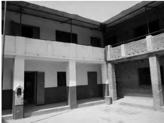
Ganesh Secondary School (左校舎の着色された柱と壁が耐震補強済み)
