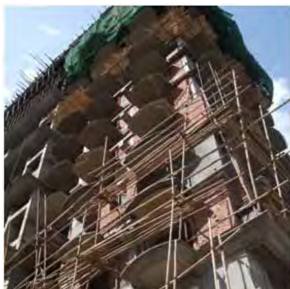
写真５－８ 現在は15階まで躯体が完成、施工は1階当たり1カ月要することもあるとか
