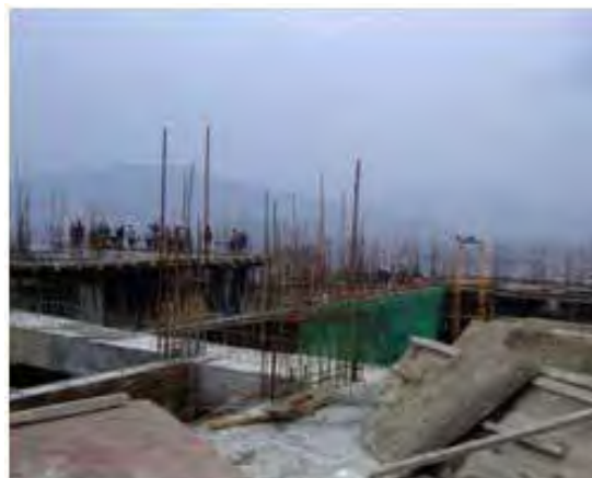
写真 5-11 コンクリートのポンプ圧送での打設状況
