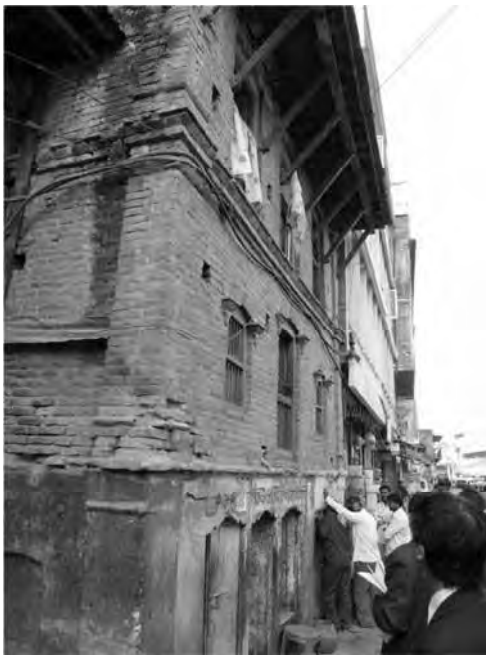
Brick Wall Building (Kalmati)
