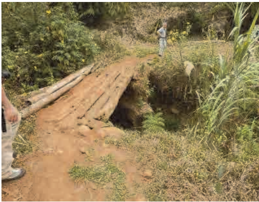
03 改修予定の橋梁 (BII)
