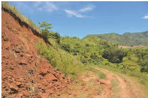
05 道路改修予定地 (section-2)
