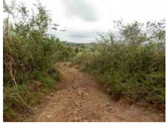
02 改修前の道路
