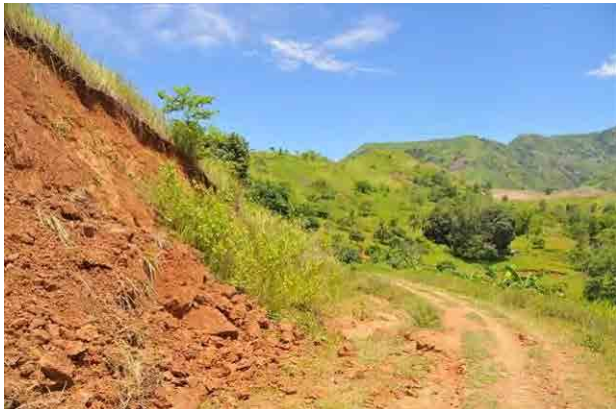
05 道路改修予定地 (section-2)
