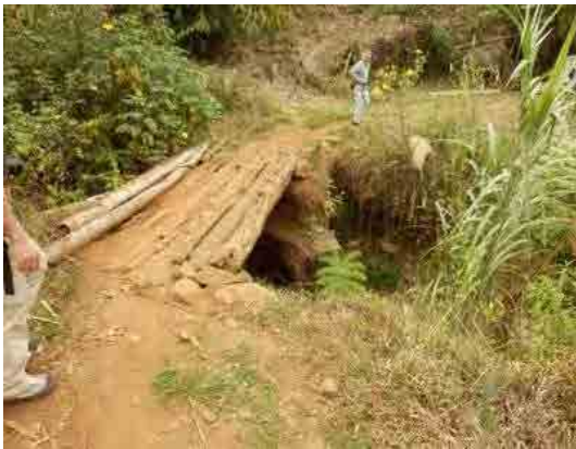
03 改修予定の橋梁 (BII)
