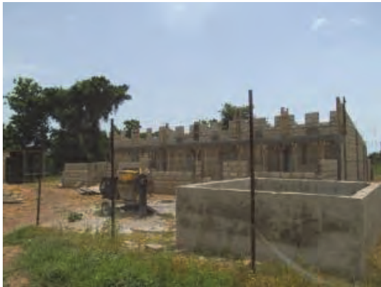
建設中の CHPS コンパウンド (Kong CHPS)
