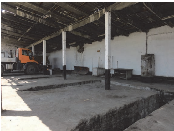
OSI UAD (ジャララバード州) DEP 45 ワークショップ建屋 整備ピット有り
