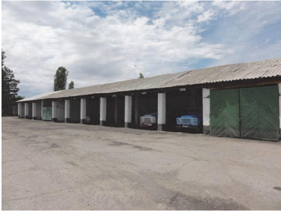
PLUAD 5 (タラス州) DEP 19 ワークショップ建屋 屋根、内外装の改装が必要
