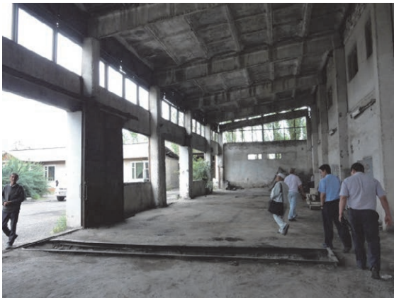
PLUAD 6 (ジャララバード州) DEP 52 ワークショップ建屋 整備ピット有り
