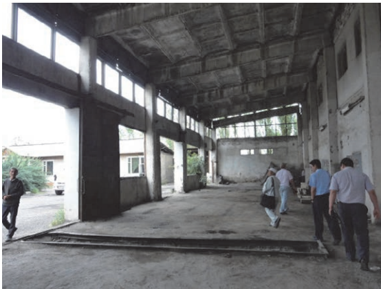
PLUAD 6 (ジャララバード州) DEP 52 ワークショップ建屋 整備ピット有り
