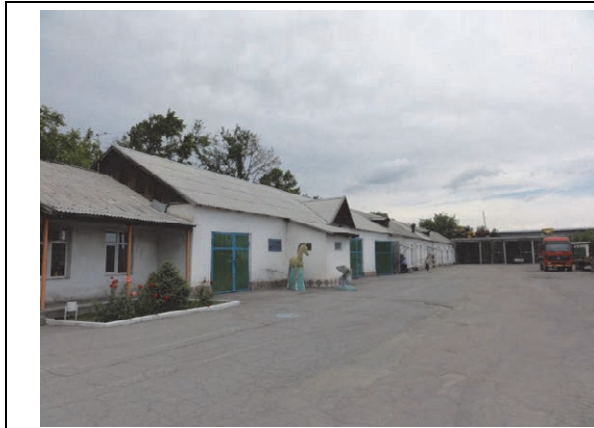
PLUAD 1 (チュイ州) DEP 958 ワークショップ建屋 照明・電源設備の改修が必要
