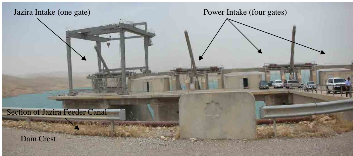
図 3.6-3 ジャジーラ取水施設
