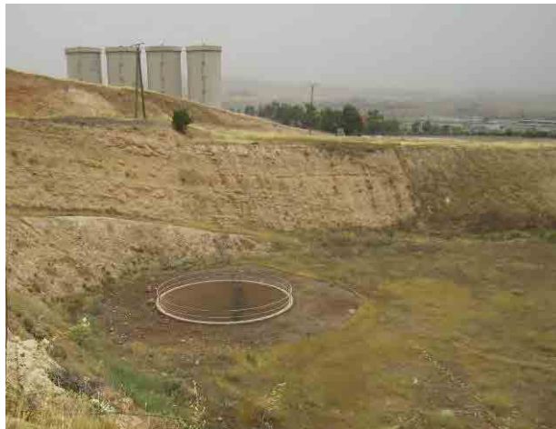
南部ジャジーラ灌漑事業用の取水口
