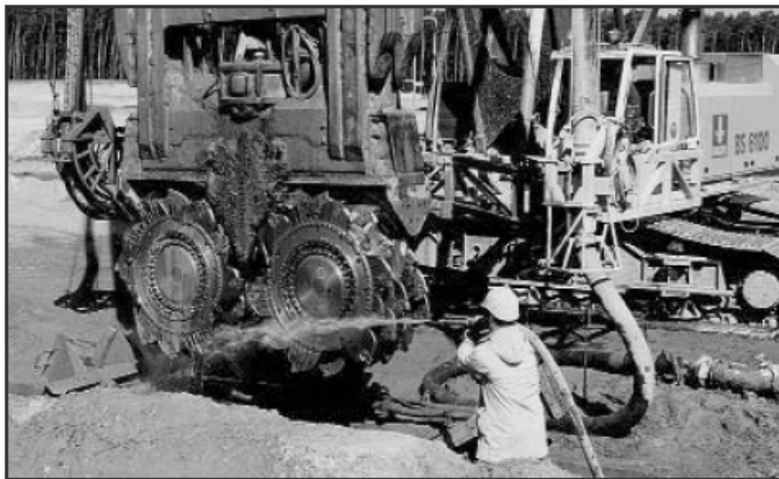
図 3.6-13 “Hydromill Type” 掘削装置
