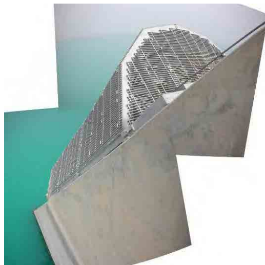
図 3.6-4 ジャジーラ取水施設の塵除けスクリーン
