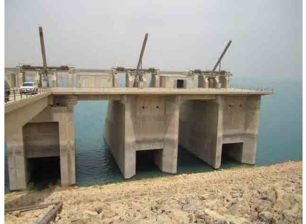
モスル水力発電所用の取水施設
