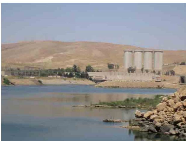
モスルダム発電施設を望む
