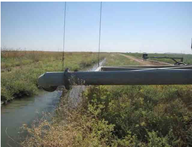
北部ジャジーラ灌漑事業での 移動式灌漑システム取水部
