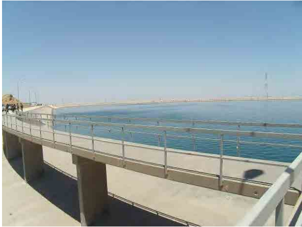
モスルダム貯水池 余水吐より望む
