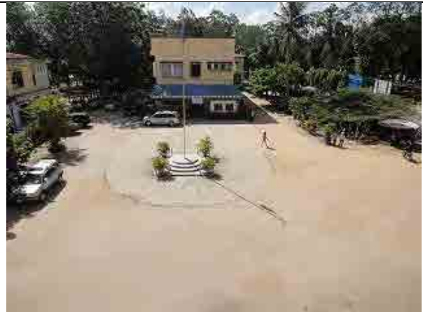
B棟と建設予定地(C棟から)
