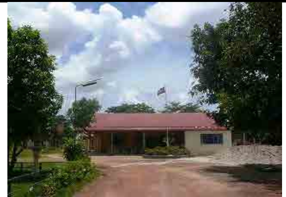
ロマエハイ病院 中央棟
