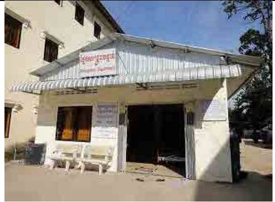
救急棟正面 入って直に病室
