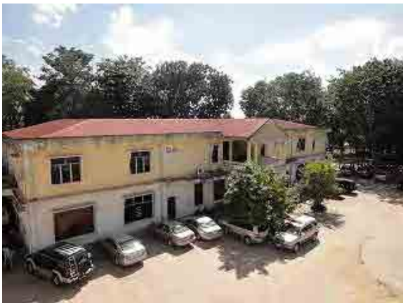
A棟と建設予定地(C棟から)
