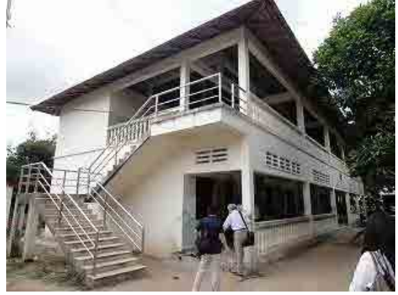
チプー病院 産婦人科棟
