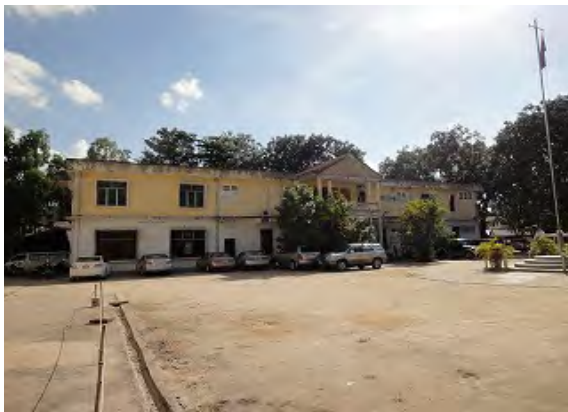
A棟と建設予定地
