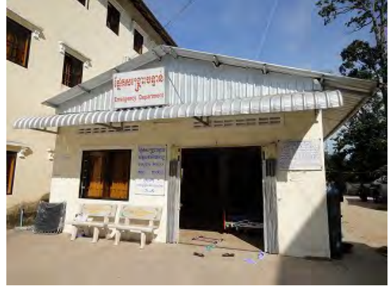
救急棟正面 入って直に病室
