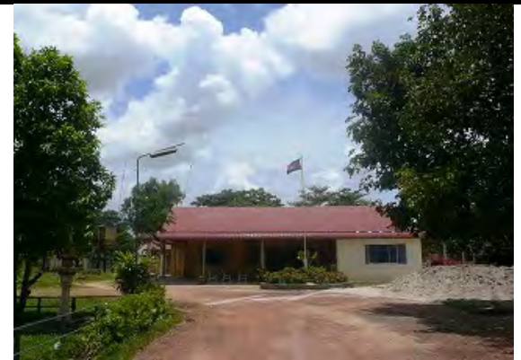
ロマエハイ病院 中央棟
