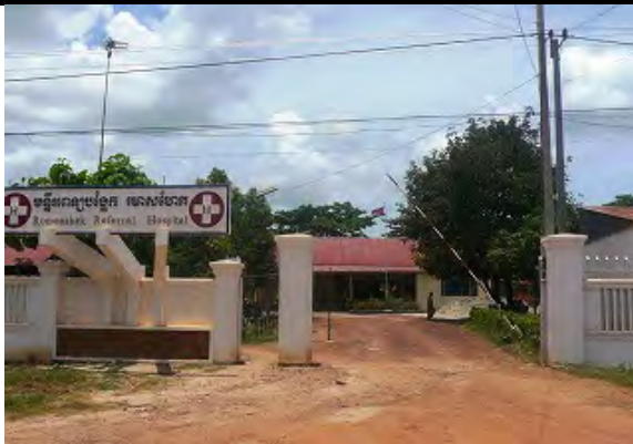
ロマエハイ病院 エントランス
