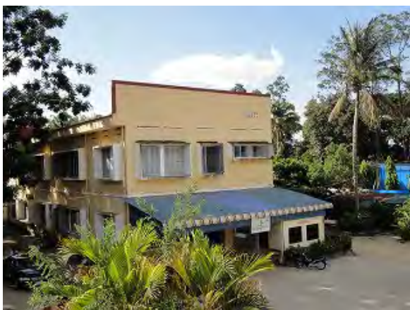
B棟 1階部分は撤去予定
