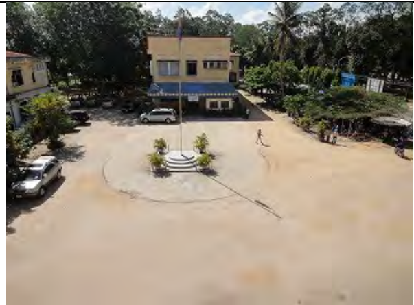
B棟と建設予定地(C棟から)
