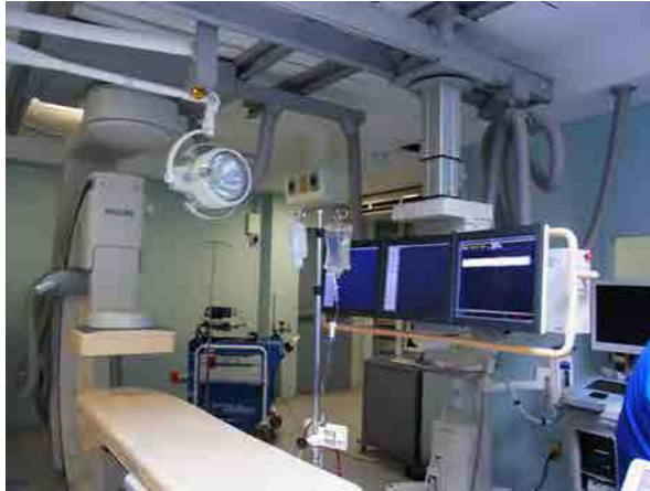
1. Hospital de ISSSTE, 20 de noviembre (Sala de angiografía)
