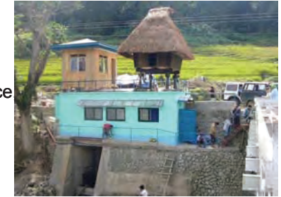
Mini Hydro Power Generation
