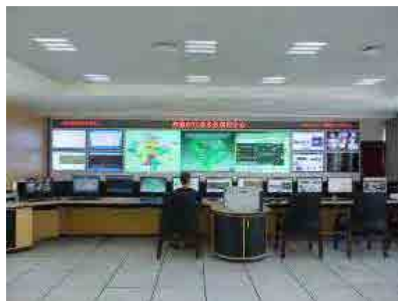
⑤周行下水処理場： 中央監視室 兼 分散処理場集中監視所
