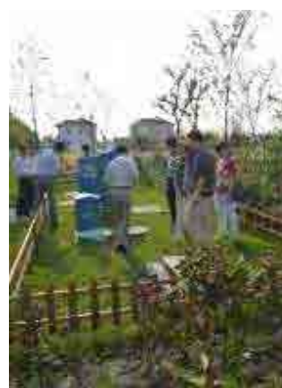
④ SBRによる工場生産型浄化施設 全景 35世帯(10m 3 /日) 6基の中1基
