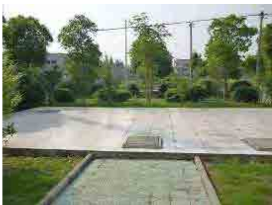
② MBR による現場打ち浄化施設 [138 世帯(110m 3 /日)] 全景 左側が調整槽、右側が反応槽
