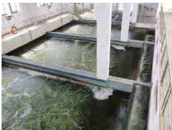
⑤周行下水処理場（嫌気・好気ろ床法） 好気性ろ床部分
