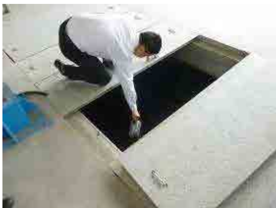
⑤周行下水処理場（嫌気・好気ろ床法） 凝集剤添加最初沈殿池部分
