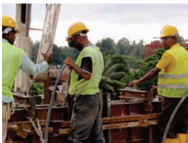
高欄コンクリート打設状況(2)
