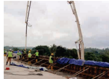
高欄コンクリート打設状況(1)
