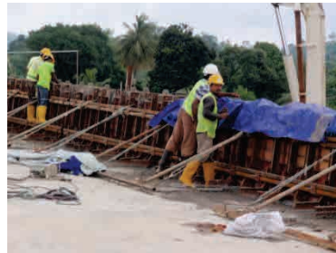
高欄型枠（外枠は合板）
