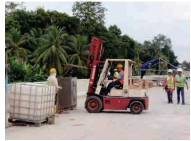
フォークリフトによる型枠移動
