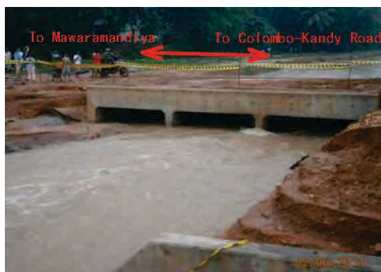
施工中のボックスカルバート
