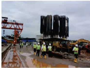
バッチャープラント
