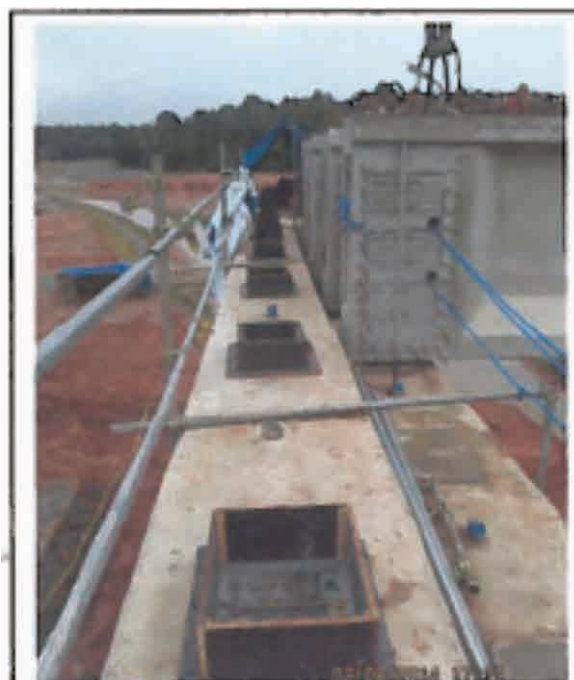
橋脚天端安全柵状況
