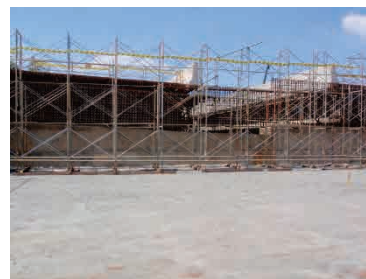
工区起点（STA17+500）
