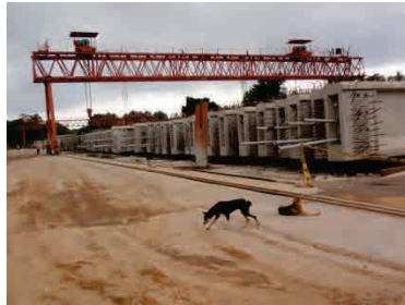
桁製作ヤード南（製作終了）
