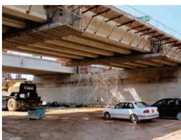
ブラケット足場状況
