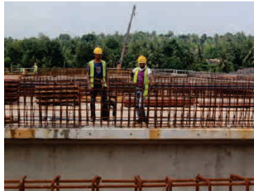
高欄打継目チッピング
