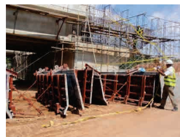
高欄型枠仮置き状況
