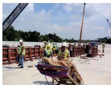
高欄施工状況とガスボンベ
