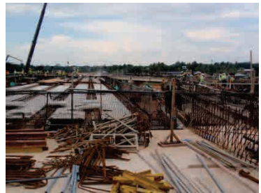
高架橋上安全柵及びネット
