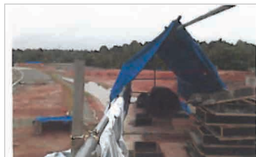
橋脚上の仮設テント（資材置場・休憩所）
