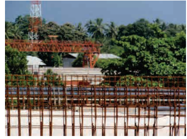
桁製作ヤード
