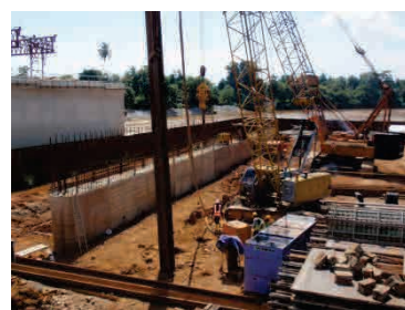
セラニ川半川締切矢板引抜き
