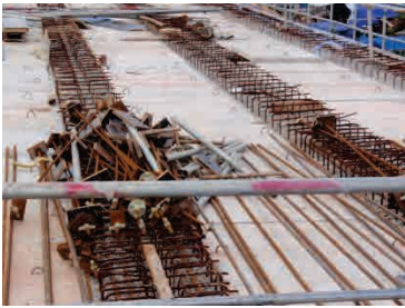
RC 床板設置状況
