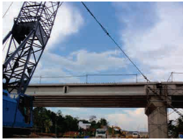
PC 桁架設状況
