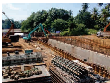
セラニ川橋脚施工状況
