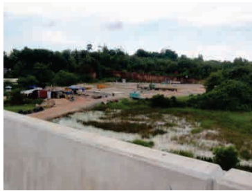
桁仮置きヤード (使用終了)
