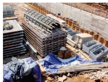
セラニ川型枠整理状況
