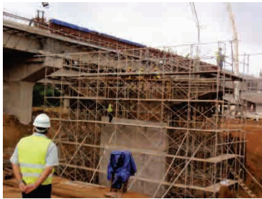
ランプ橋脚足場
