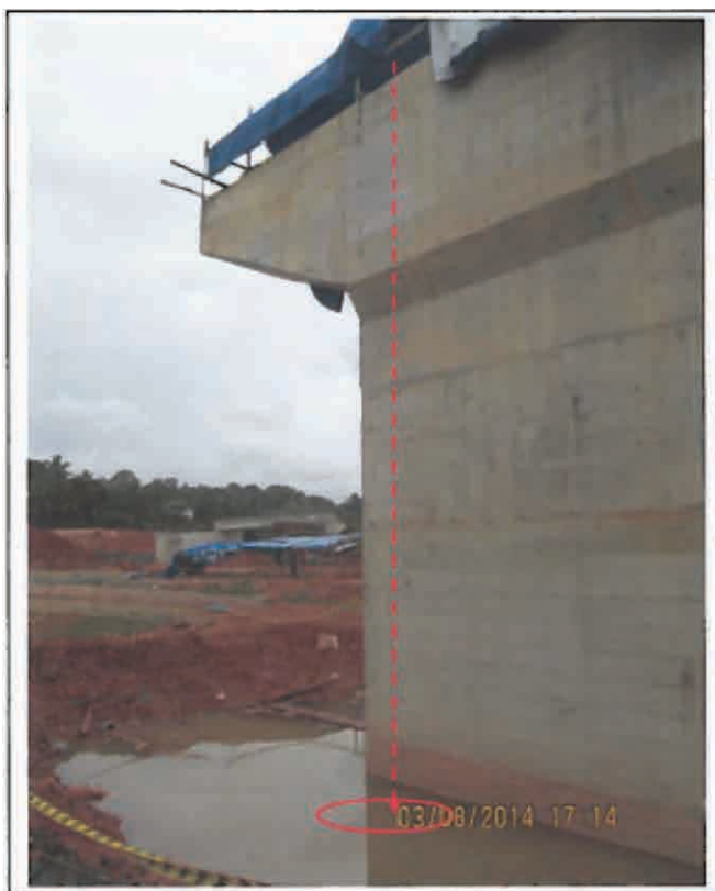
橋脚から下の水溜りに転落した
