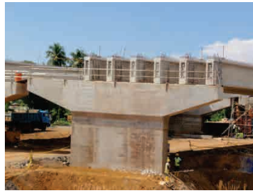
PC 桁端部と橋脚
