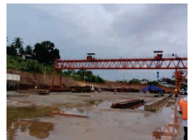
桁製作ヤード北（資材置き場）
