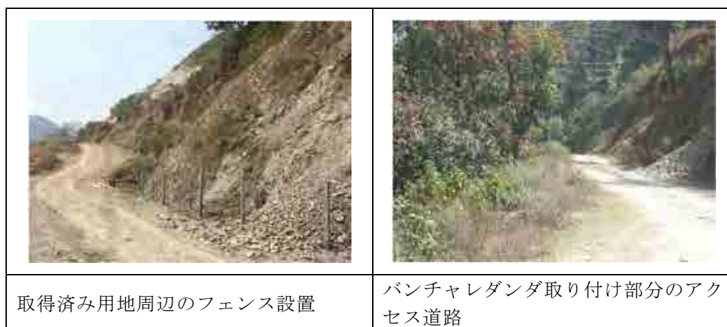
写真 3-5 バンチャレダング処分場付近での準備状況
