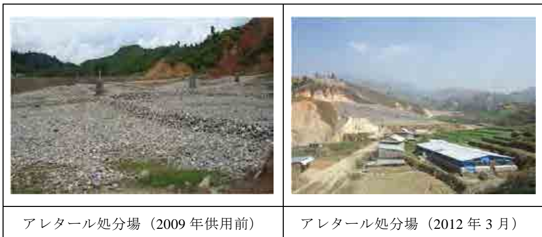
写真 3-1 アレタール処分場の状況
