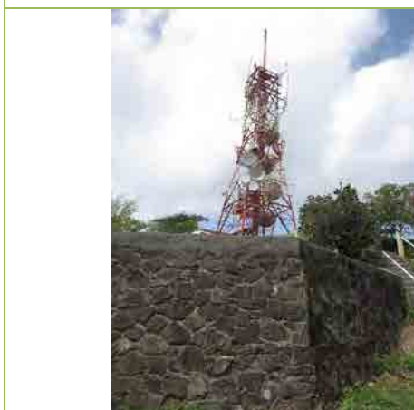
写真-5： マウントオバマにある既存電波塔
