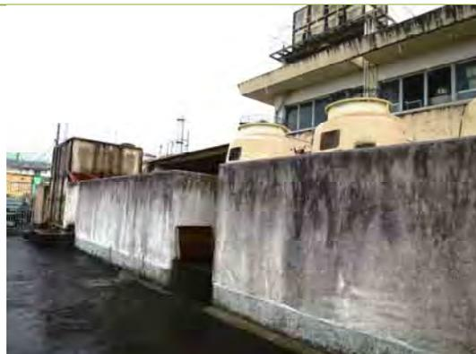
写真-2: ロゾー水産コンプレックスの水冷コンデンサー (4基) (老朽化、1基は完全に使用不能)
