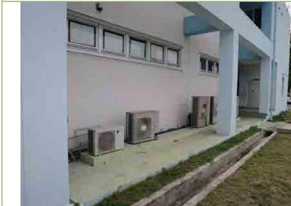
写真-3： ポイントワーフ水産センターの空調機(写真は室外機、スペアパーツが調達不能)
