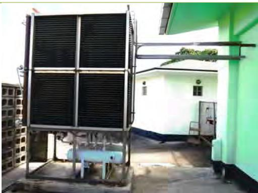
写真-1： バセテール水産コンプレックスの空冷コンデンサー（老朽化により熱交換性能が低下）
