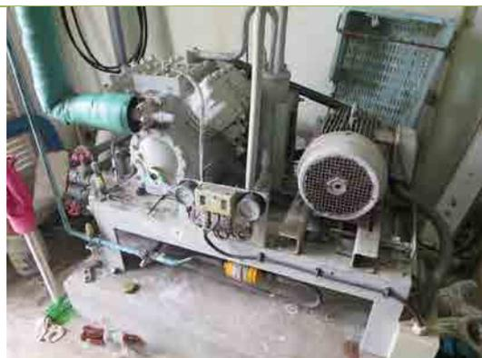
写真-4: マリゴット漁港内の冷蔵庫用冷却設備 (老朽化)
