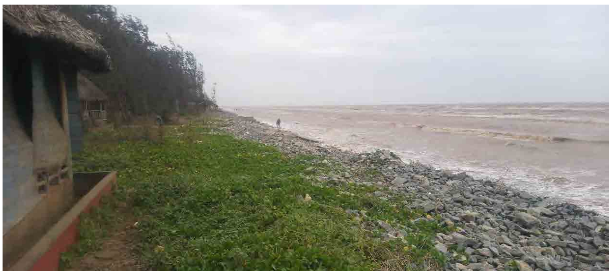
写真 2.1.2 ズーエンハイ石炭火力発電所の北方約 3km のリゾートの海岸の状況 (海浜侵食防止のため の採石が投入されている) 調査団撮影
