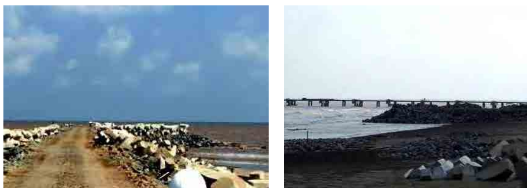
写真 2.4.2 建設中の防波堤と石炭荷揚棧橋 (2014 年 3 月 : 調査団撮影)
