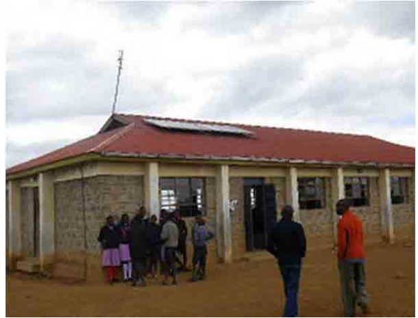
Iltumtum 小学校に設置された太陽光パネル
