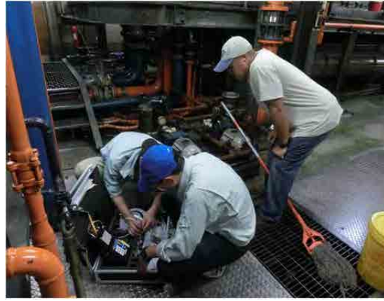
Majuro7 号機 燃料流量測定 (C/P へ測定手法の指導)
