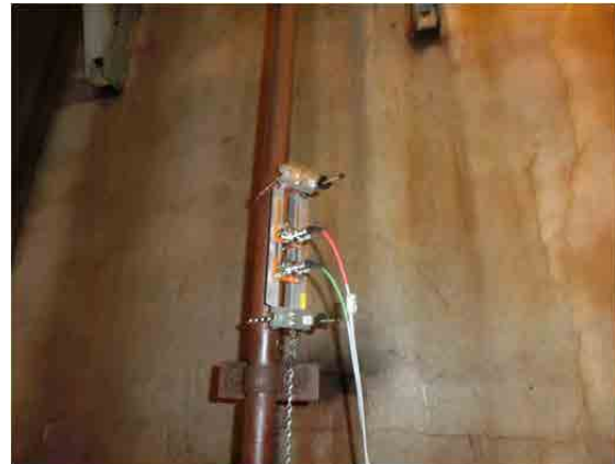
Majuro5 号機 燃料流量計センサー設置 (持ち込み計測器)
