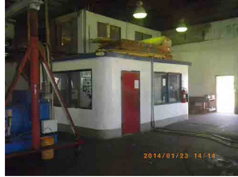
発電機制御室
