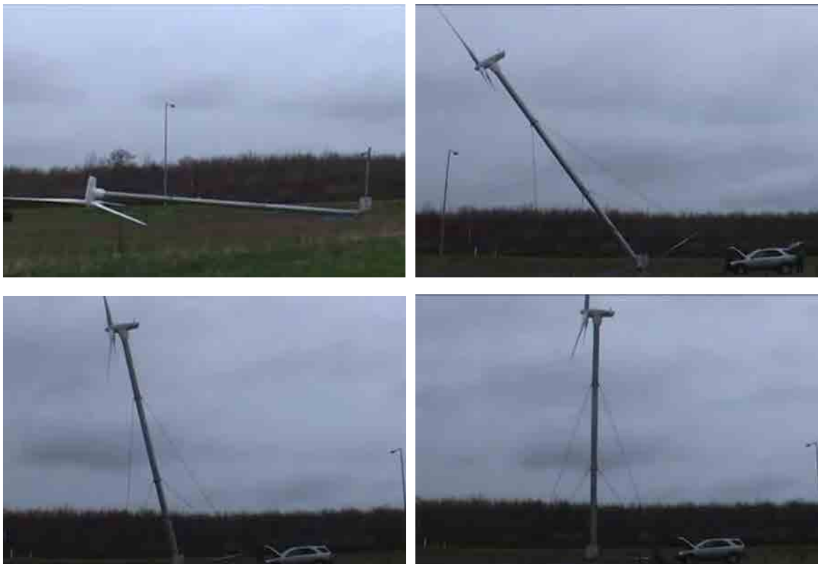
図 3.3.3-11 風車傾倒状況
