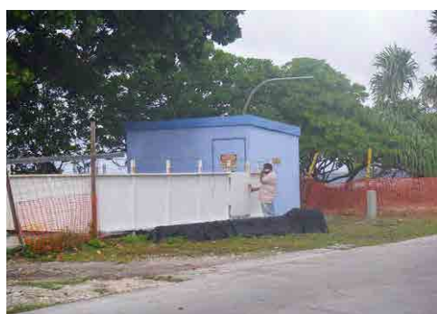
空港 VCB 建屋
