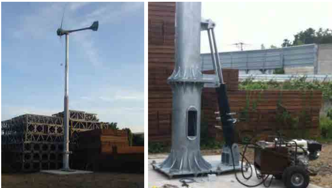
図 3.3.3-6 風車メンテナンス状況
