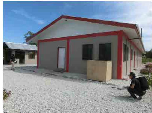
Wotje 環礁 PV 設置候補地調査
