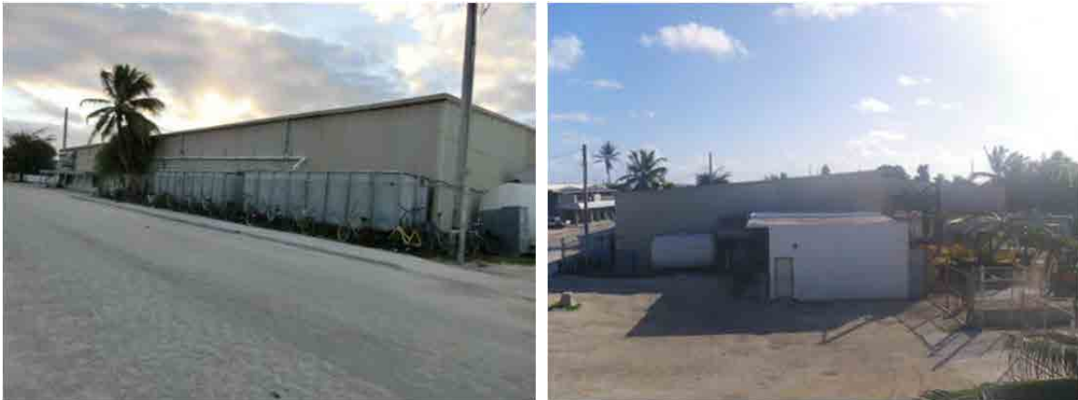
図 3.3.5-8 設置候補場所の状況
