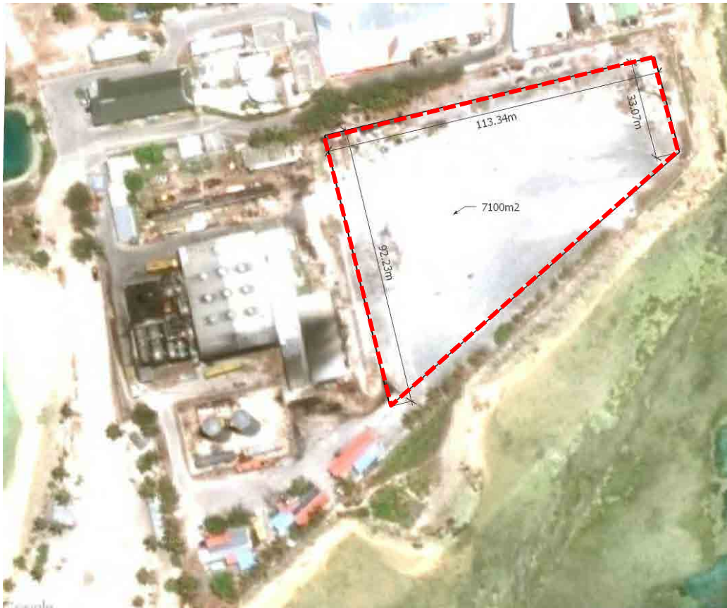
図 3.3.5-7 発電敷地境界
