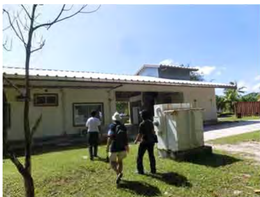
Jaluit 環礁 PV 設置候補地調査
