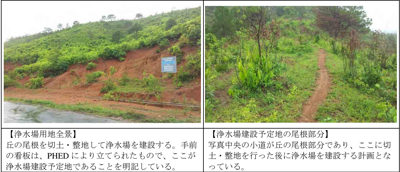
写真 5.3 Chingkeiching 浄水場建設予定地
