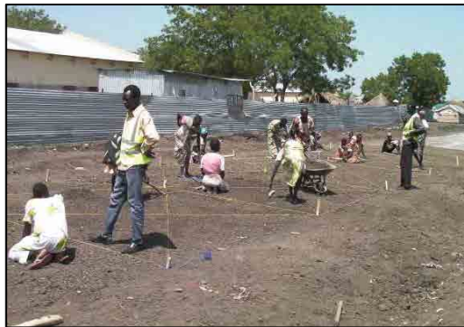
労働集約技術工法(LBT)による道路工事
