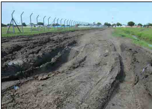
コミュニティ道路 (黒綿土と呼ばれる黒色の粘土質土壌)
