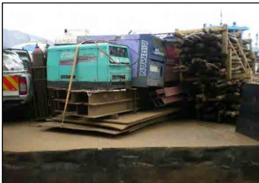
ジュバ河川港における本事業の 建設資機材の荷積み
