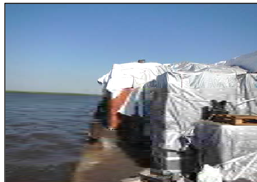
建設資機材の河川輸送 (ジュバ～マラカル間)
