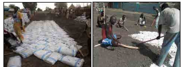
土嚢の杉あや方式設置状況
