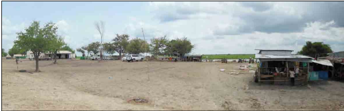
浄水施設の建設予定地
