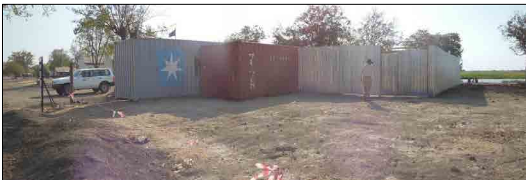
建設資機材の保管の様子 (建造物の撤去及び整地後)
