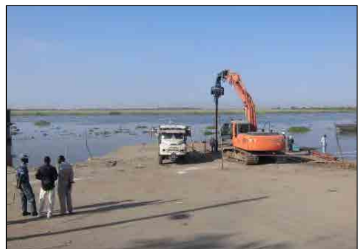
棧橋用シートパイル打設
