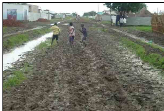
雨季に泥濘化する道路 (上部はLBTによる道路建設現場)
