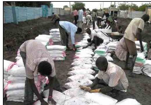
土のうによる LBT 路床工事
