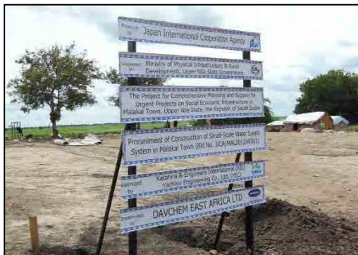
プロジェクト掲示板の設置
