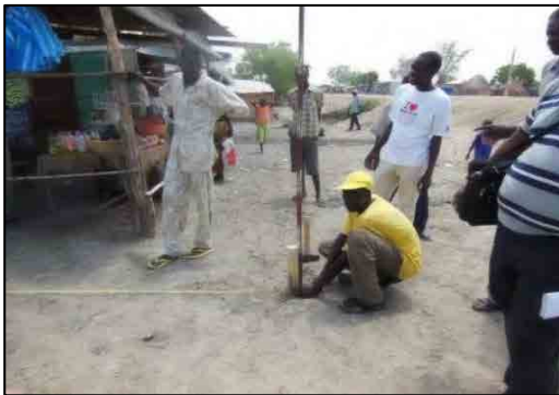
区画確定のための測量作業
