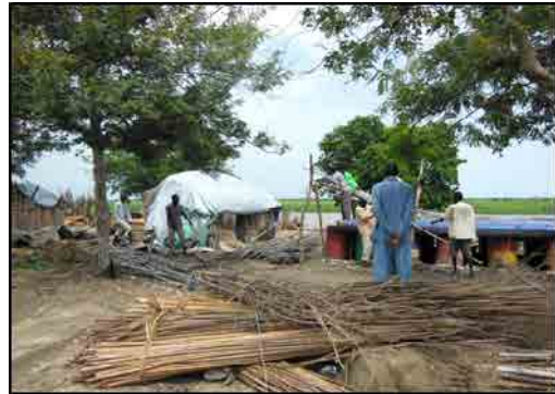
既存の建造物の移転
