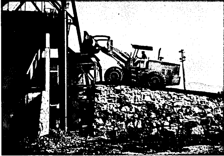
坑外コンクリート運搬
