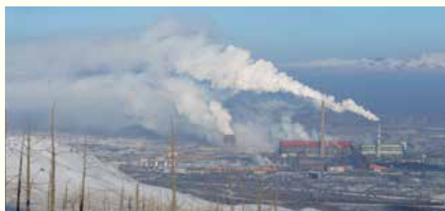
Une épaisse fumée s'échappe d'une centrale électrique.
