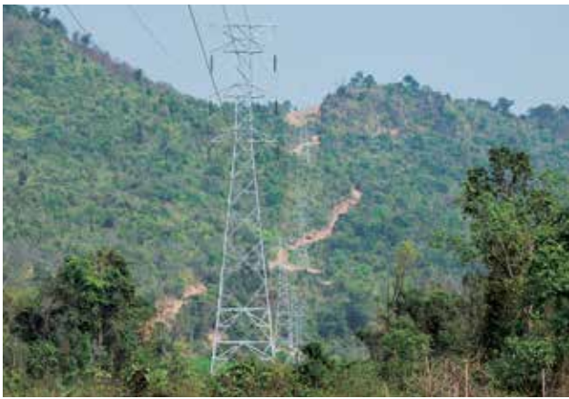
Cette ligne de transmission s'étire sur près de 40 km depuis la sous-station de Paksane et traverse Pakkading.
