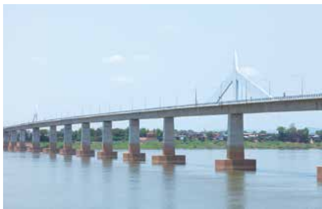
Le second pont international du Mékong, qui relie la Thaïlande et le Laos, a été financé par un prêt d'APD. Le projet fait partie de la construction d'un corridor est-ouest qui s'étendra du Vietnam au Myanmar.
