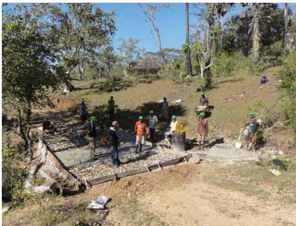
Des habitants construisent une route communautaire (Timor-Est)
