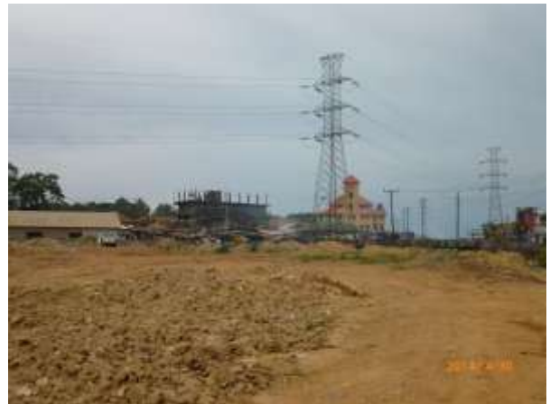
仮設資材置き場
