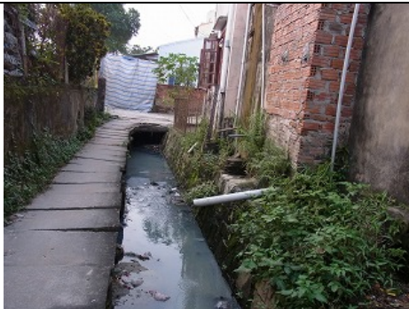
写真-3：下水処理施設予定地より上流の開渠区間 下水処理施設予定地の上流は、日本橋水路にホテル等からの排水が流入している
