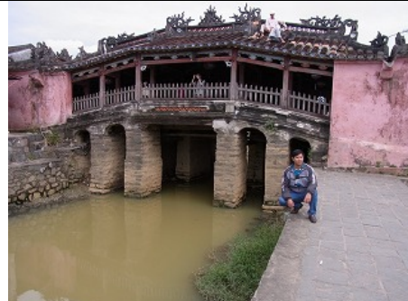
写真-8：日本橋下流側の日本橋水路（逆流時） 潮汐の影響により、逆流時は合流先のホイアン川の水が日本橋水路を遡上する（2013年12月撮影）
