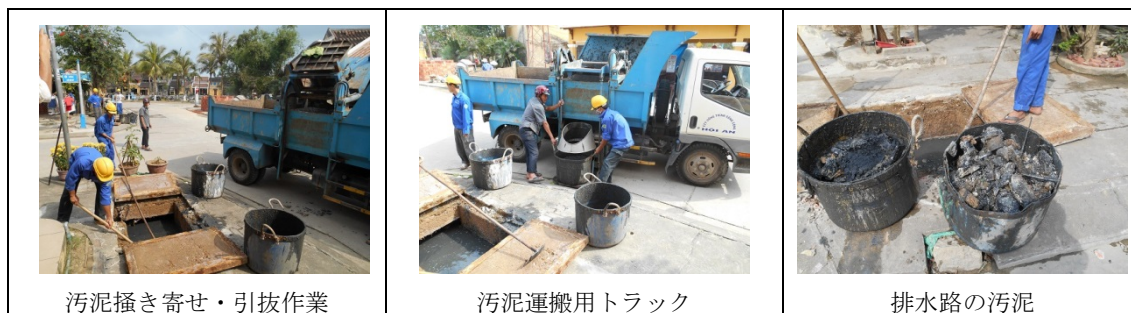
写真 2.1.3-1 PWC による既存排水路の維持管理状況
