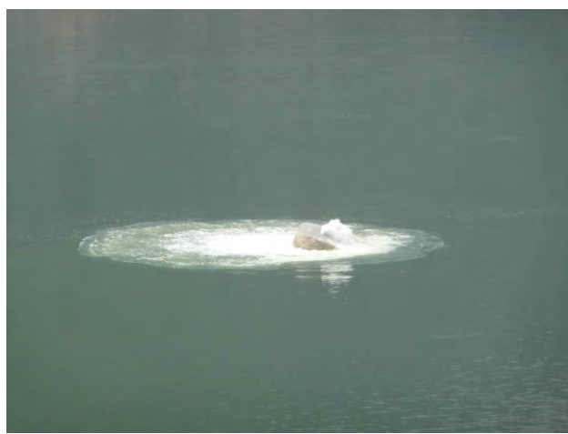
照片-7 曝气设备运行状态 2012年7月27日 黑河金盆水库
