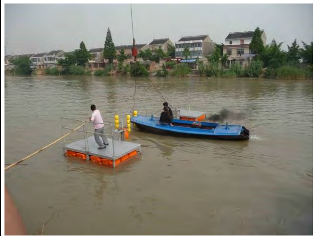
照片-36 门开关试验 2014年5月28日 扬州
