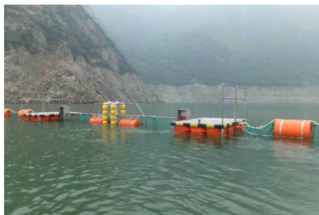
照片-37 拦污网·通船门设置状况 2014年6月30日 黑河金盆水库
