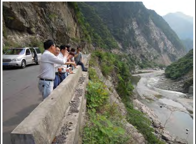
照片-4 专家现场勘查 2012 年 5 月 8 日 黑河上游流域
