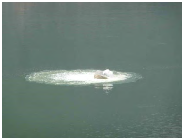
写真-7 揚水曝気装置稼動状況 2012年7月27日 黒河金盆ダム湖
