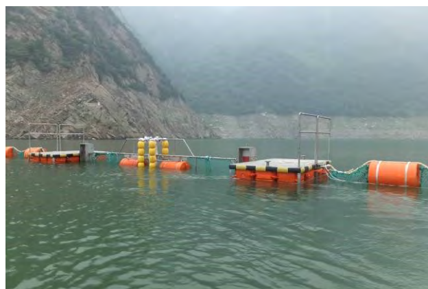
写真-37 網場・通船ゲート設置状況 2014年6月30日 黒河金盆ダム湖
