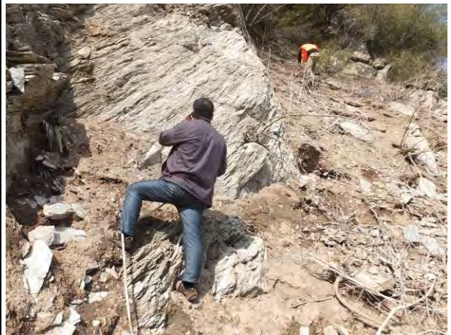
写真-28 網場用アンカーの設置に関する簡易測量 2013年10月23日 黒河金盆ダム湖
