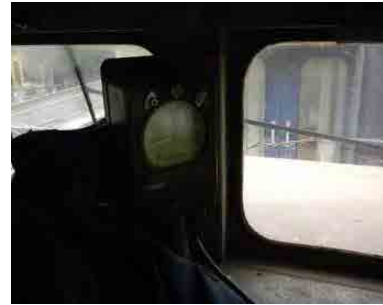
写真 46 故障している速度計
