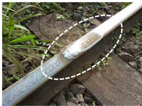
写真 2.3.42 レールの空転傷 (Kojokrom～Angu)
