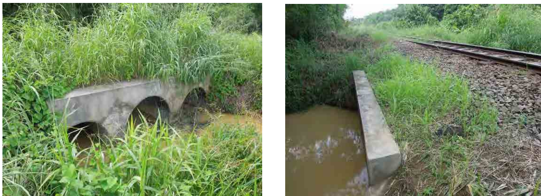
図 2.3.2 Armco Pipe を使用した河川切り廻し
