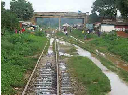
写真 2.2.7 排水が線路内を川のように流れる駅構内 (Kojokrom 駅構内、西線)
