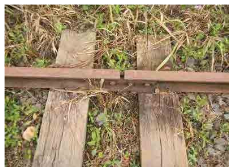
写真 2 運行休止区間の軌道状態
