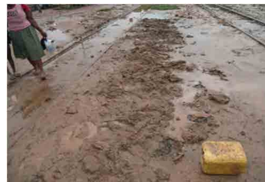
写真 2.3.33 線路内に流入した水と土砂 (Kojokrom 駅構内)
