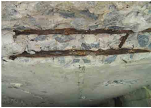
(a) コンクリートの剥落
