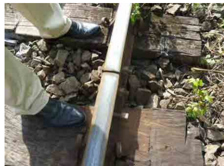
写真 2.3.46 継ぎ目ボルトの欠落とナットの弛緩 (Kojokrom～Angu)
