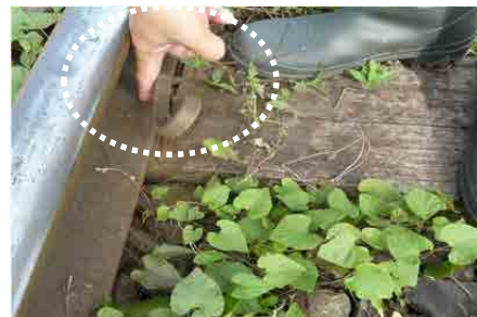
写真 2.3.40 レールベースから浮き上がったシャンク・スパイク
