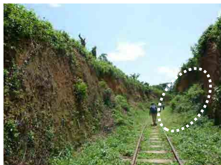
写真 2.2.9 垂直に近い法面の一部崩落 (Maudaso~Ankwaso、Awaso 支線)
