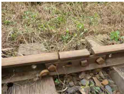
写真 2.3.45 レール継ぎ目遊間に挿入された極短小レール (Dunkwa～Awaso)
