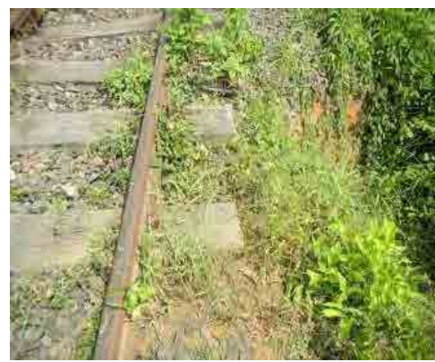
写真 2.3.14 路盤崩壊 (その2)
