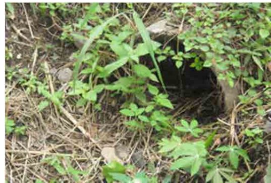
(b) 土砂に埋もれた線路横断排水路
