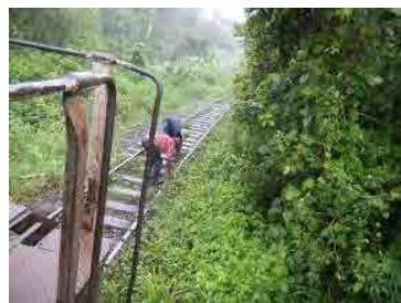
写真 76 空転復旧作業 (その 2)
