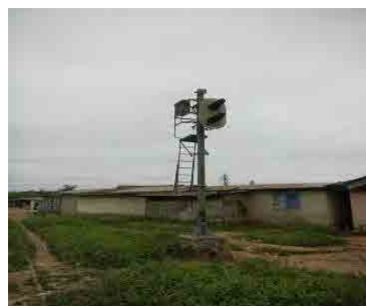
写真 14 写真旧式の場内信号機 (2 現示)
