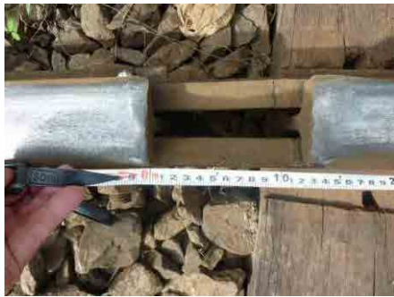
写真 2.3.43 130mm を超える過大遊間継ぎ目 (Kojokrom～Angu)
