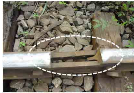
写真 2.3.44 破損している継ぎ目レール端部 (Kojokrom～Angu)
