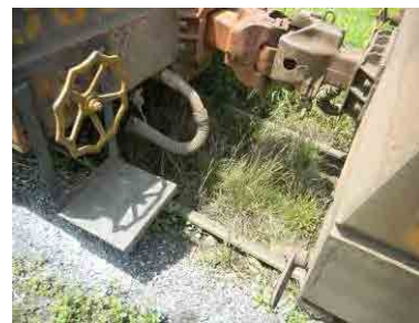
写真 66 ブレーキホース不備
