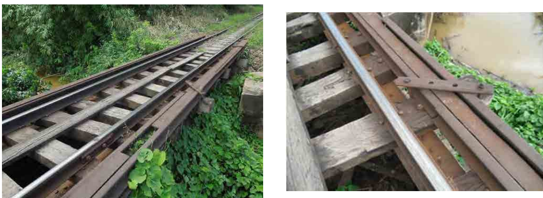
写真 2.3.36 レール桁による軌道防護
