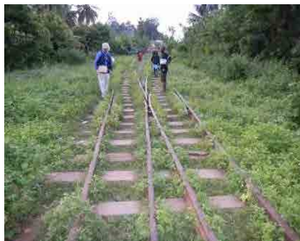
写真 9 Awaso 支線の分岐点 (Dunkwa 駅構内)
