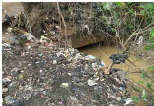
写真 2.3.32 ゴミが堆積したカルバート (Kojokrom 駅構内)
