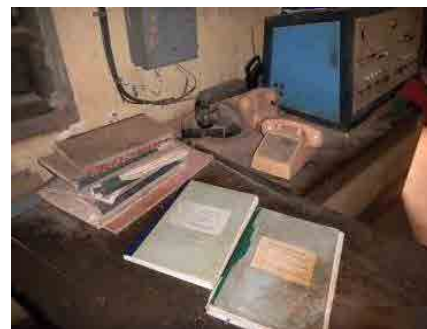
写真 22 旧通信装置 (その 2)
