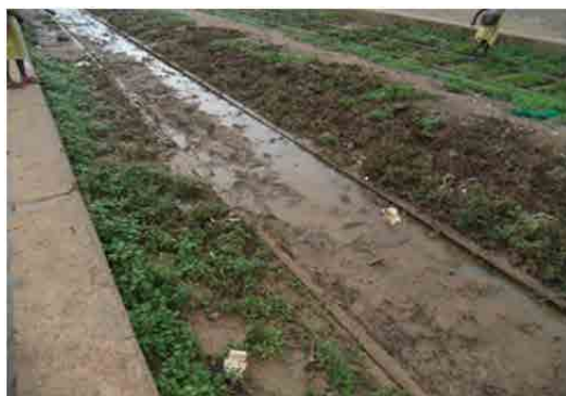
写真 2.3.33 線路内に流入した水と土砂 (Kojokrom 駅構内)
