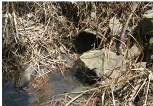
(b) 土砂に埋もれた線路横断排水路
