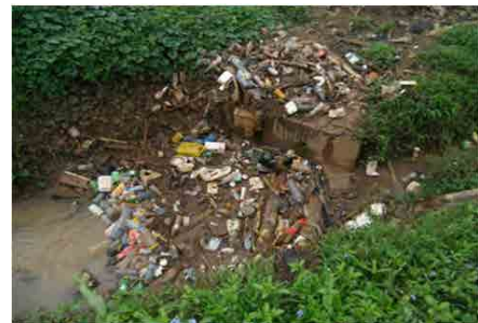
写真 2.3.32 ゴミが堆積したカルバート (Kojokrom 駅構内)
