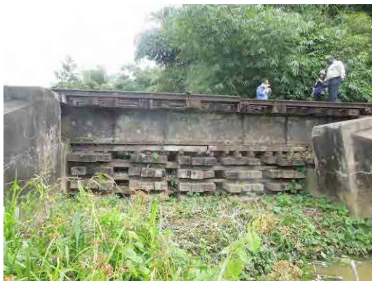
写真 2.3.34 枕木で仮受けした鋼桁橋梁
