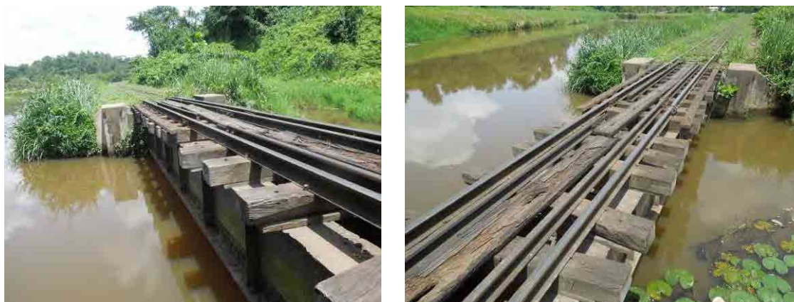
(a) 鋼製上路プレートガーダー橋梁
