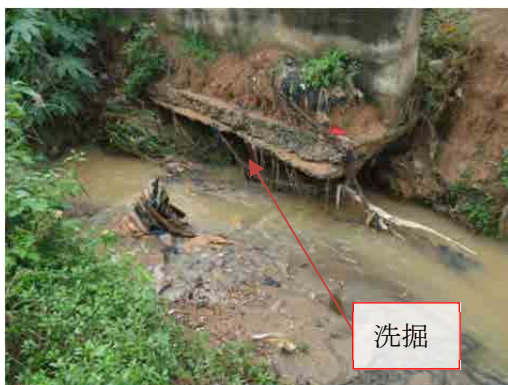
写真 4.2.37 ガーナでの洗掘されている擁壁基礎
