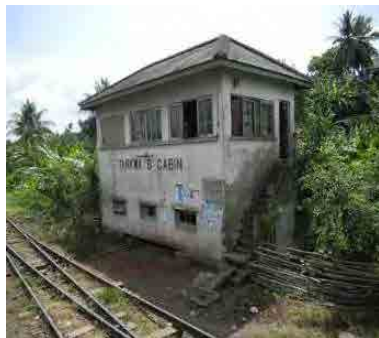
写真 43 Tarkwa 駅信号所
