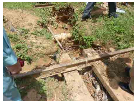
写真 2.2.10 住宅地からの流水により削り取られたバラストと路盤 (Maudaso~Ankwaso、Awaso 支線)
