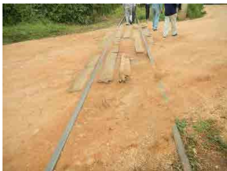
写真 1 踏切のレール状態
