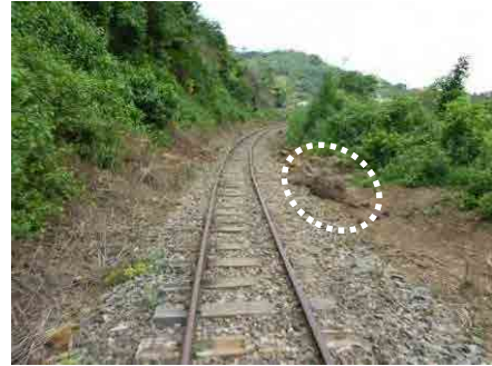
写真 2.2.8 落石が線路脇に放置されている現場 (Dunkwa~Buabin、西線)
