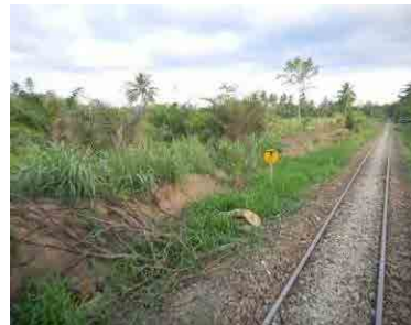
写真 58 速度制限解除標識
