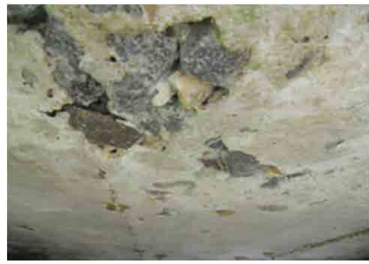
(a) コンクリートの剥落
