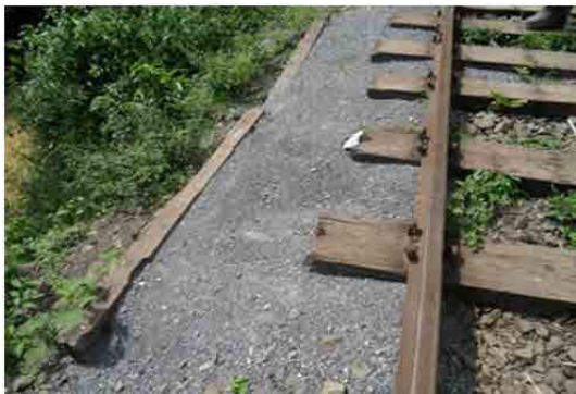
(b) 簡易土留による緊急対応箇所
