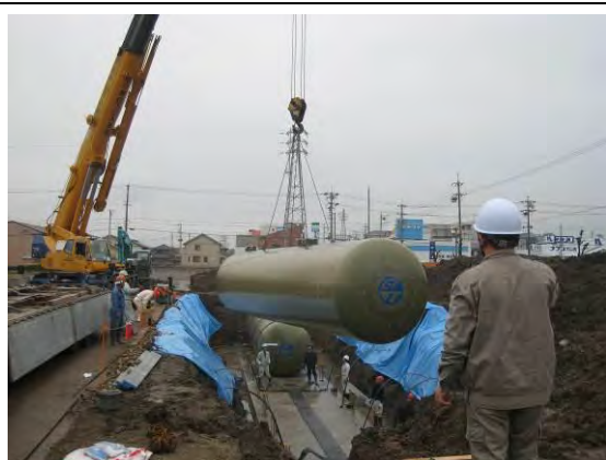
PJT5：埋設工程視察の様子
