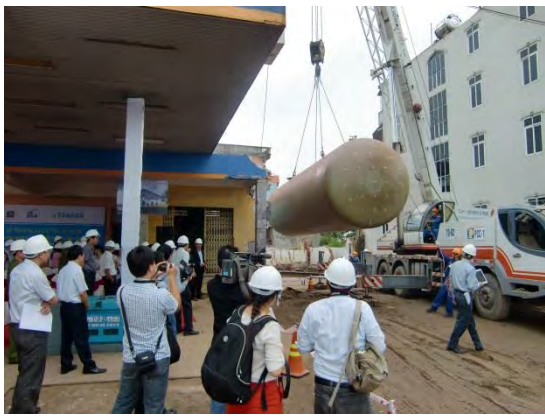
PJT6：タンク埋設の様子
