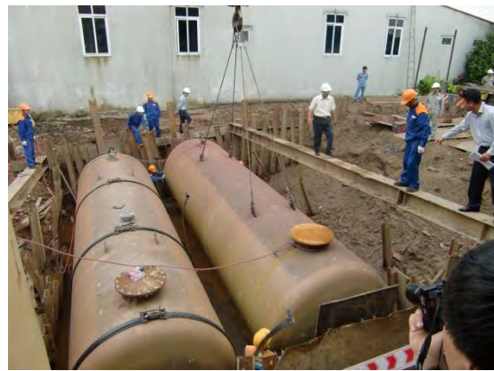
PJT6：タンク埋設の様子
