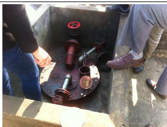
PJT1：タンクのマンホールの様子
