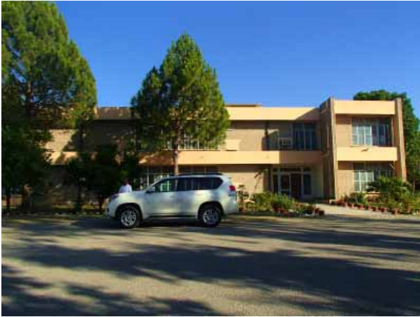
写真 1 : 研修棟 (Tarbela 研修センター)
