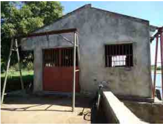
インタボ灌漑地区ポンプ場
