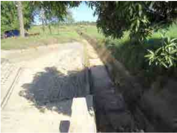
ポンプ場に接続する幹線水路（導水路）
