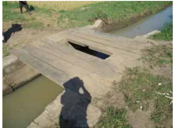
N1 水路に設けられた水路横断橋
