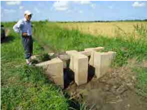
N1 水路に設置されたチェックゲート（水位調整）
