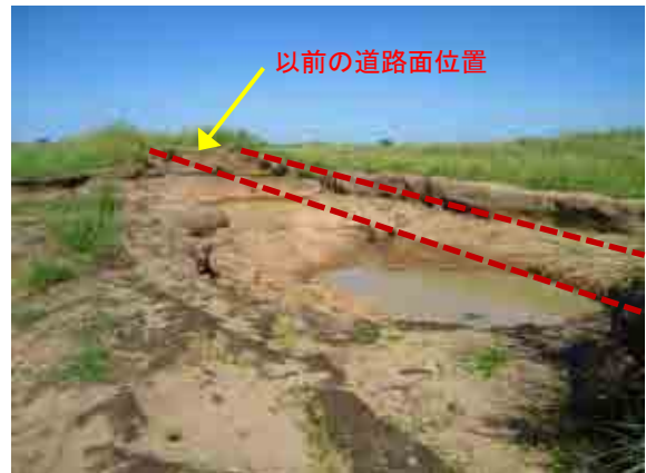
ナンテ～インタボ間の道路で洪水被害を受けた地点
