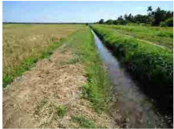
幹線水路（N1 水路）（左側が受益地）
