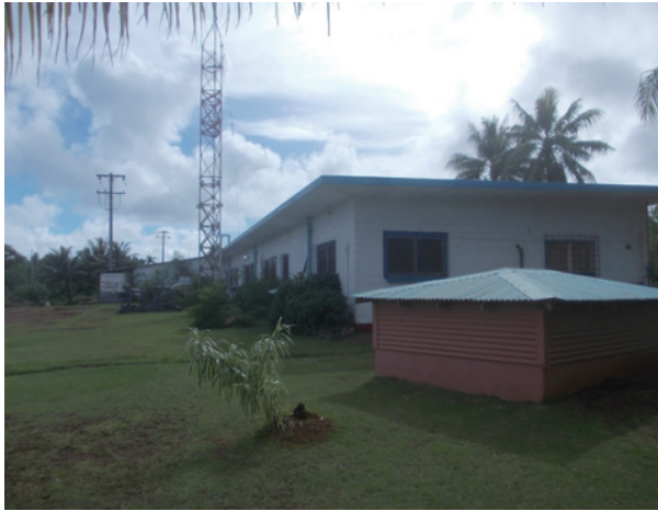
校舎、機関科、航海科及び漁業科 の教室と実習室
