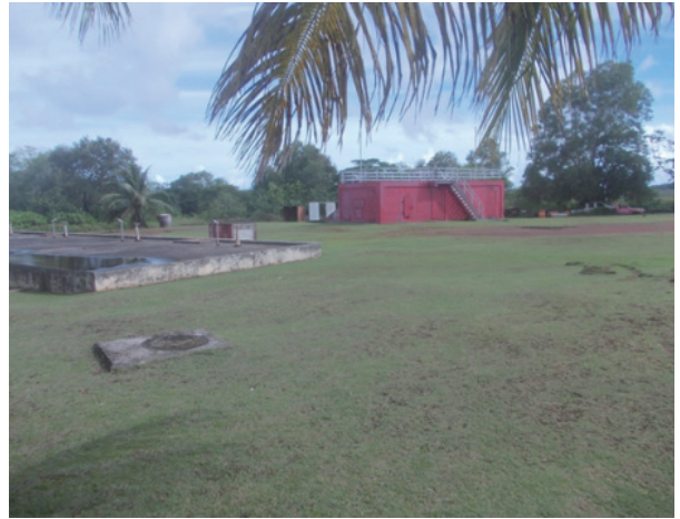
消火訓練用施設と水槽
