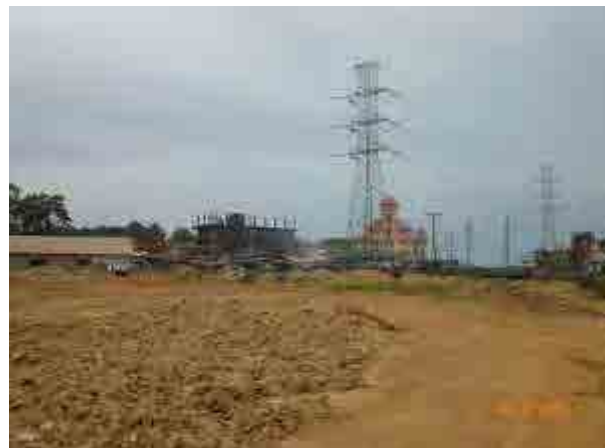
仮設資材置き場
