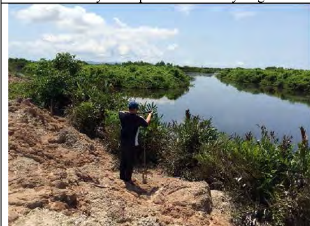
Ph-29 khu vực đầm nhà Mạc Lấy mẫu lớp đất mặt
