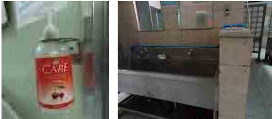
写真 3. 2. 2. 3 病院内手指消毒環境の現状(2013 年 3 月)
