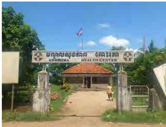
写真 3.2.4.1 ヘルスセンター外観
