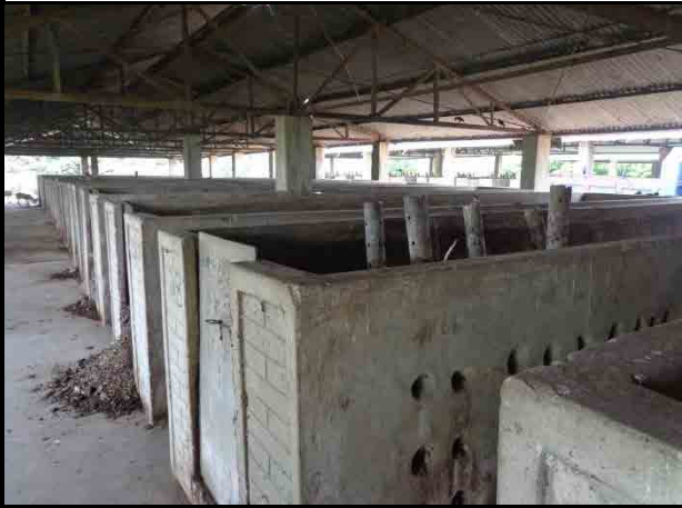
ハリシャハール処分場内の コンポストプラント(チッタゴン市)
