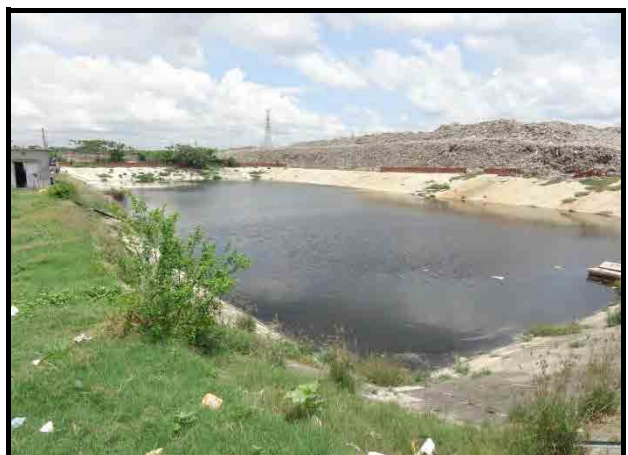
マトワイル処分場(浸出水処理曝気槽) (南ダッカ市)
