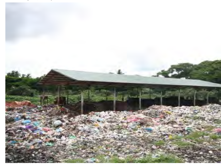
既存処分場 (Kurunegala MCにて) の一 部を利用してコンポストプラント (Windrow式、2010年3月) を建設。
