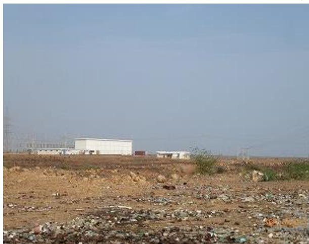
ジャバナス変電所の外観
