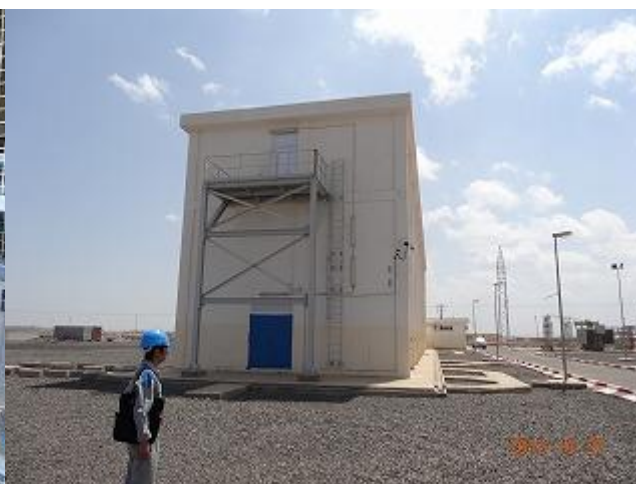
63 kV 開閉設備用建屋の新設予定地
